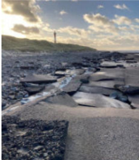
erneut massive Schäden am Deckwerk entstanden. Bei der Herbstdeichschau wurde dieser Küstenschutzabschnitt von den Mitarbeitern der Wasserstrassen- und Schifffahrtsverwaltung aus Wilhelmshaven (WSA/WSV) noch als „sicher“ bezeichnet.
